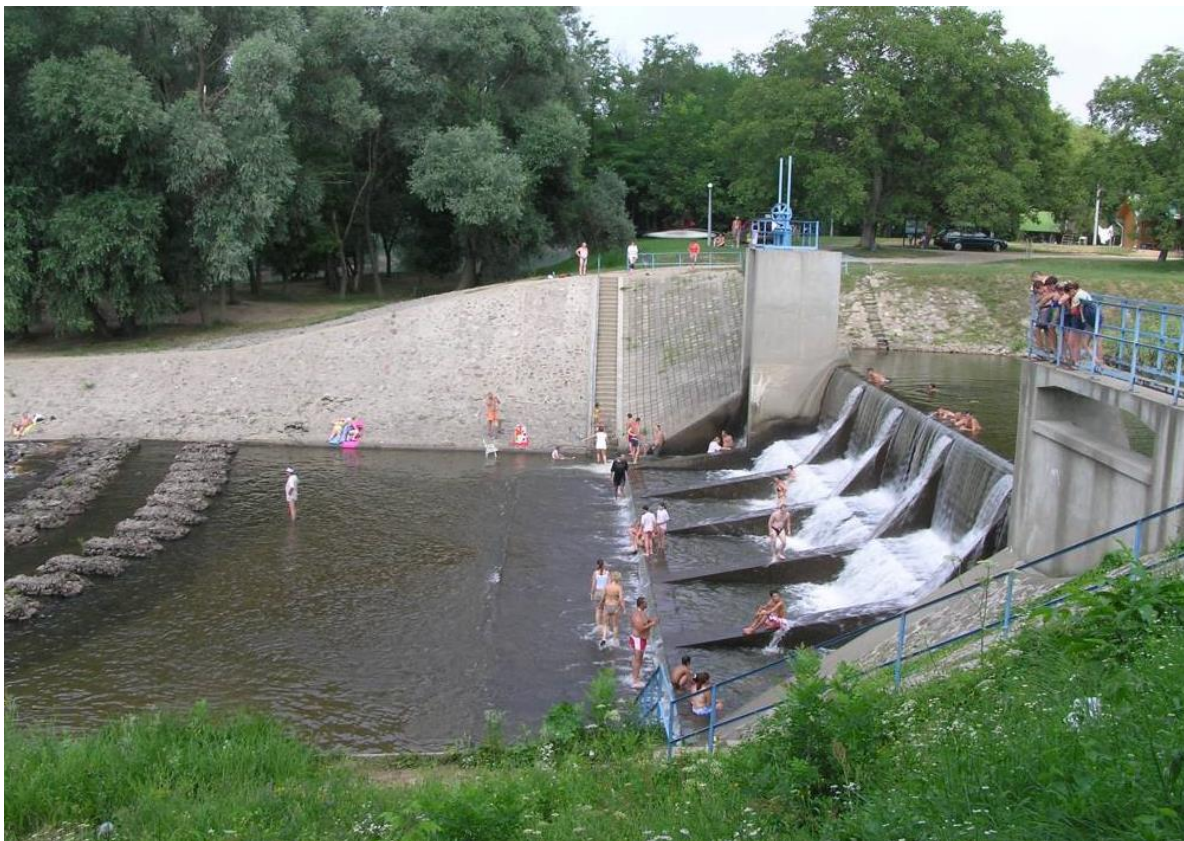
4.20. ábra: A Túr-csatorna torkolati bukója Forrás: szatmartour.hu
